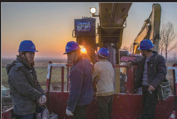
▲的工作,搭乘工地吊车回住地 夕阳西下,父亲和工友们结束一天
