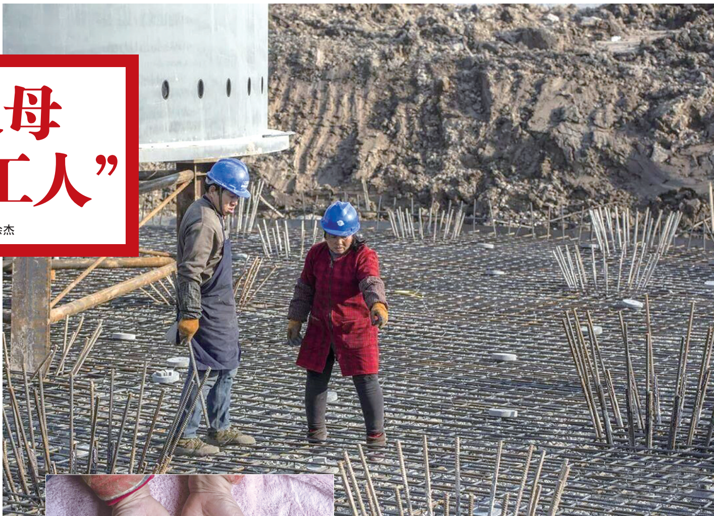
▲建筑工地上,父母相互配合绑扎钢筋
