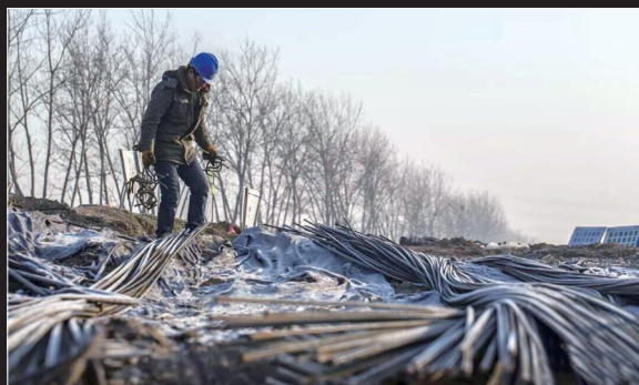
▲气寒冷,钢筋上附着着厚厚的霜 吃完早饭,父亲开始搬钢筋,天
