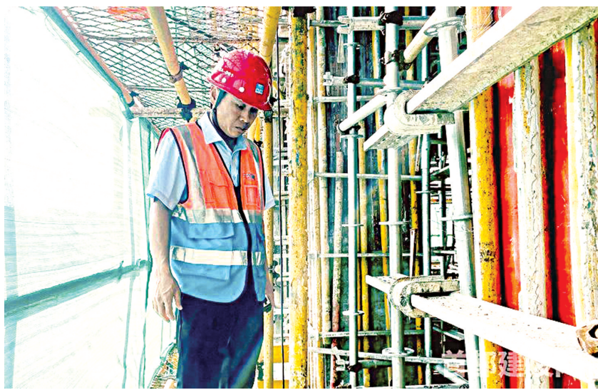
■杨建忠检查项目安全设施
